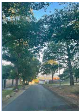
Ulice Lesní po rekonstrukci.
