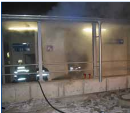
Pokladna na modernizovaném hořovickém nádraží po řádění vandalů.
